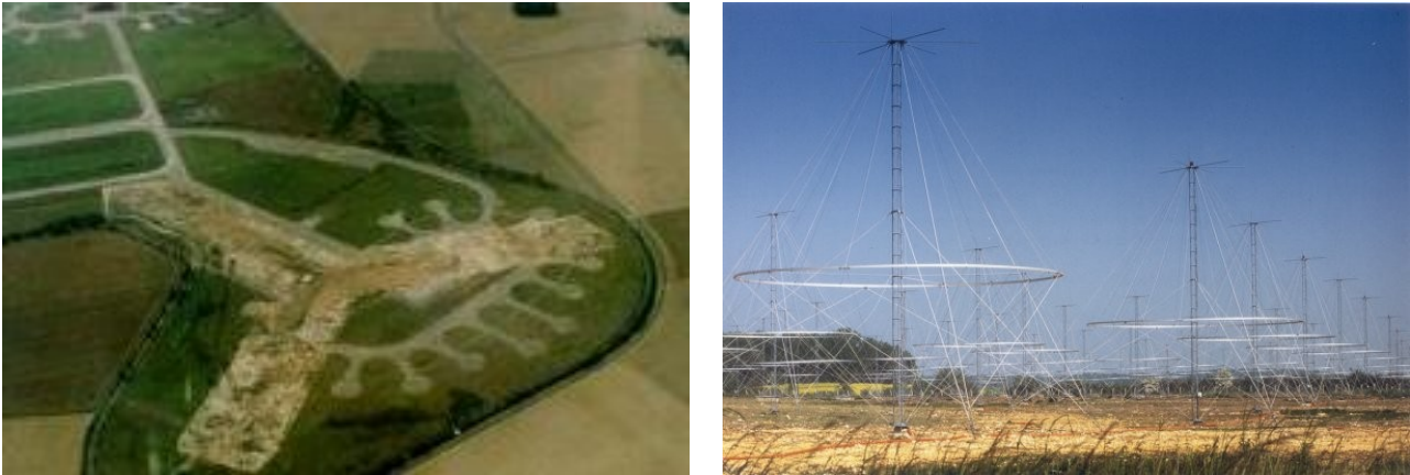
Figura 1.13. Disposizione del parco antenne e dettaglio delle antenne del sistema NOSTRADAMUS.
